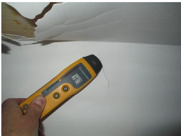
Figure 42- Relevés au protimètre indiquent un taux d'humidité normal
