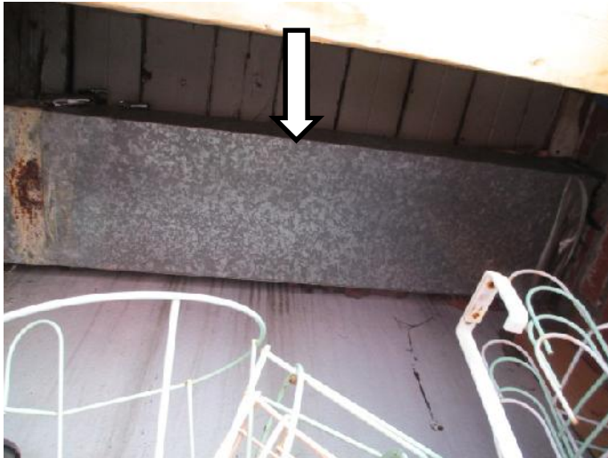
Figure 46- Conduite de ventilation passant dans un espace non chauffé
