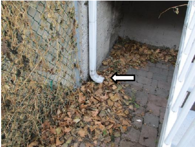
Figure 16- Évacuation trop près de l'immeuble
