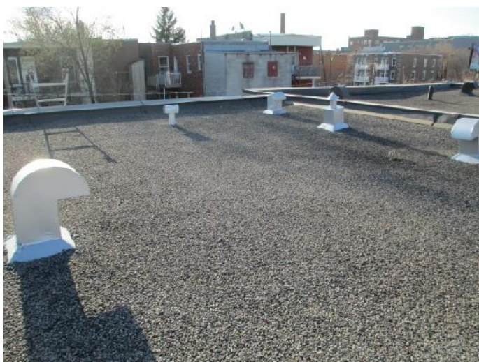
Figure 4- Vue partielle de la toiture vers l'arrière
