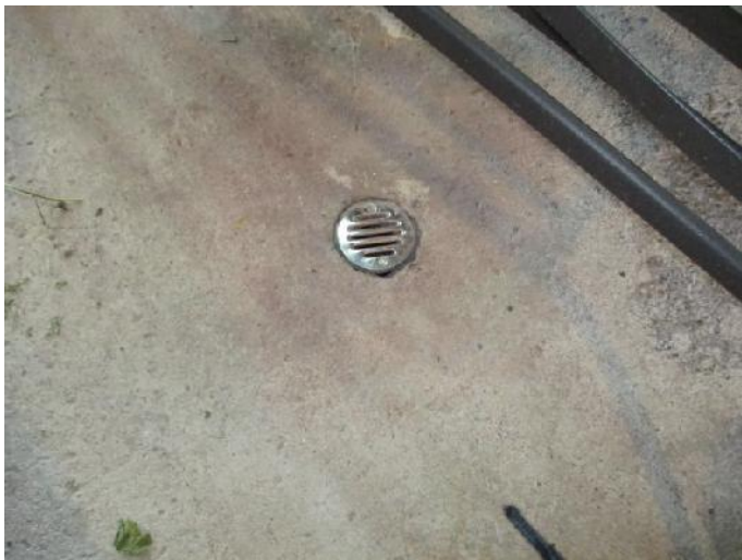
Figure 34- Le drain au garage n'est pas branché
