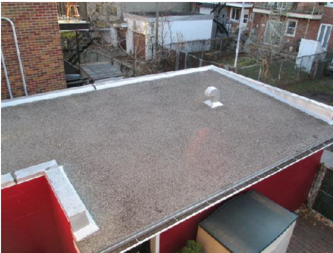
Figure 7 – Vue de la toiture du garage
