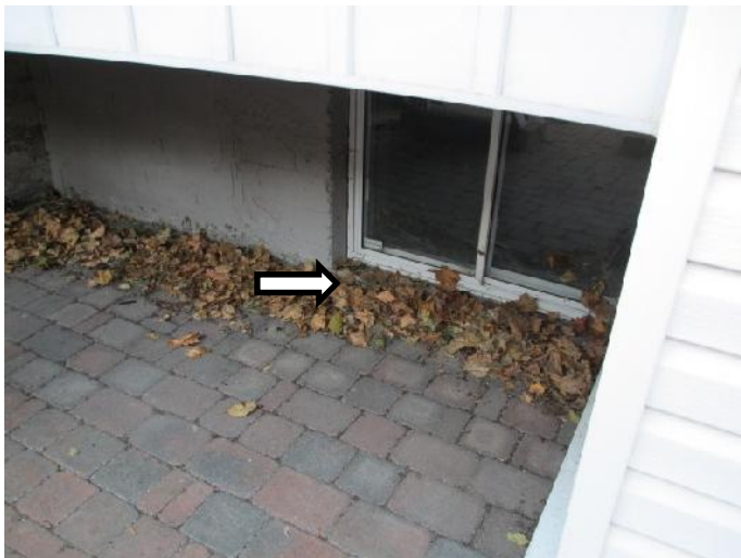
Figure 17- Dégagement insuffisant entre le seuil de fenêtre et le sol
