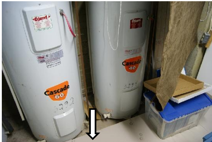
Figure 43- La dalle de béton est cassée sous le faux plancher
