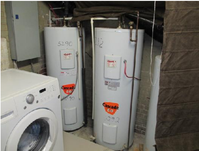
Figure 39- Chauffe-eau installés à la salle de chauffage au sous-sol
