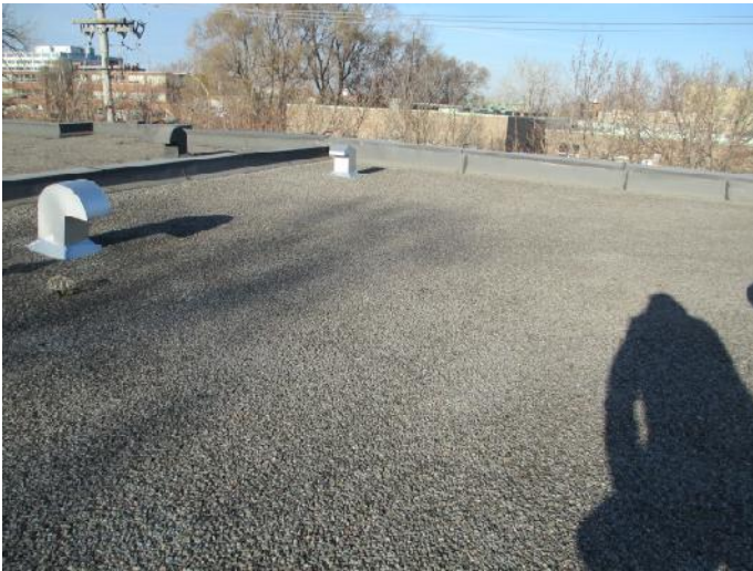
Figure 1- Vue partielle de la toiture vers l'avant
