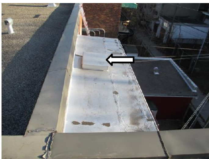
Figure 5- Trappe d'accès pour la toiture
