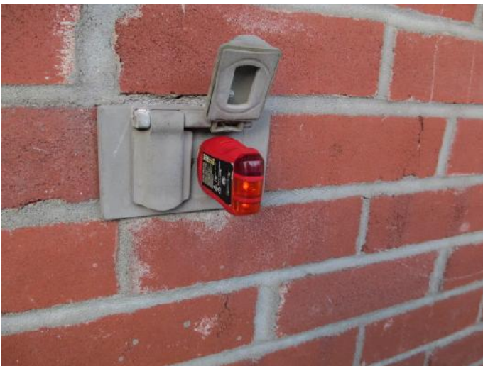
Figure 22- Prise extérieure à l'arrière au 5290 non protégée
