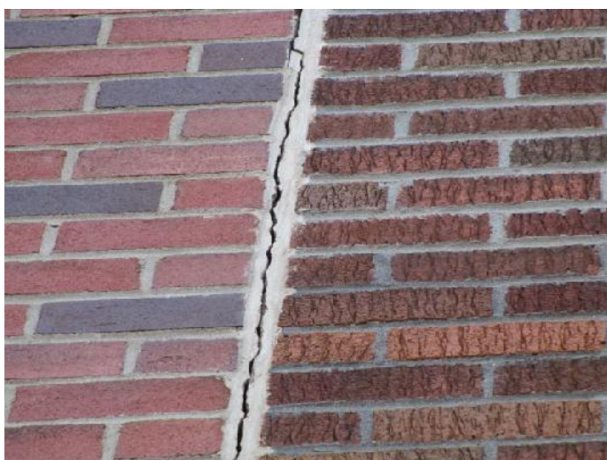
Figure 11- Joint de mortier mitoyen fissuré
