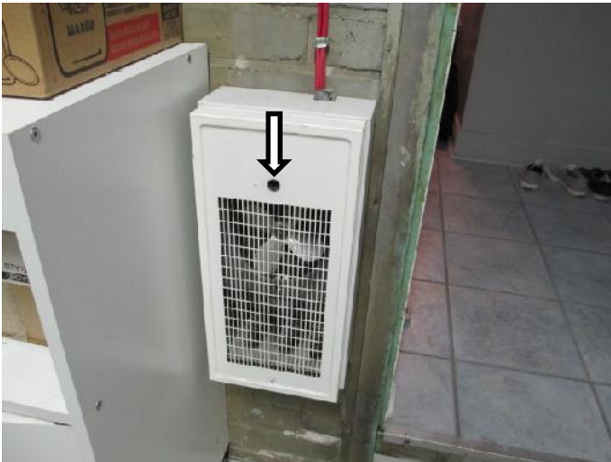
Figure 25- Bouton de contrôle absent sur le convecteur
