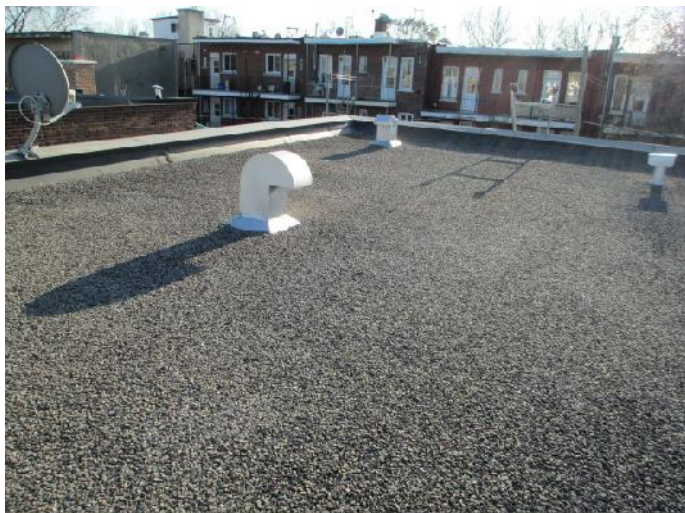
Figure 3- Vue partielle de la toiture vers l'arrière
