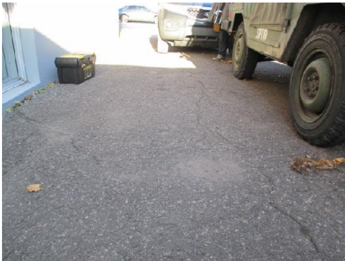
Figure 15- Pavage d'asphalte fissuré et en fin de vie
