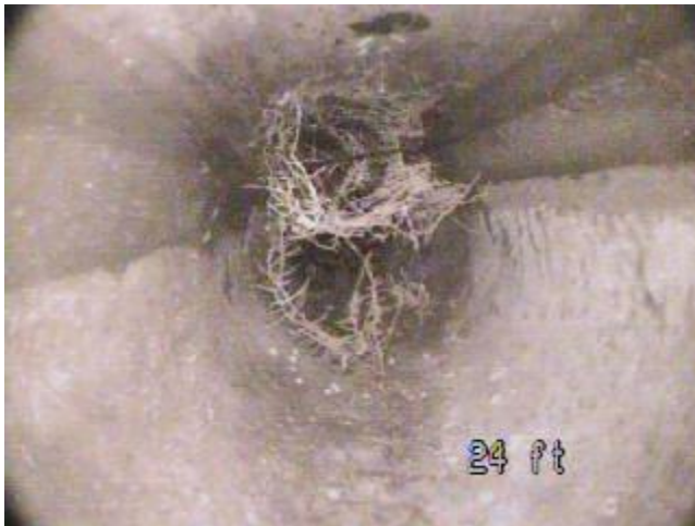
Figure 31 - Racines récentes à 24 pieds du regard de nettoyage
