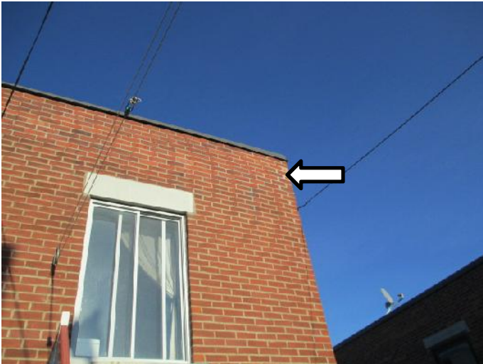
Figure 8- Joints de mortier fissurés au coin gauche arrière supérieur
