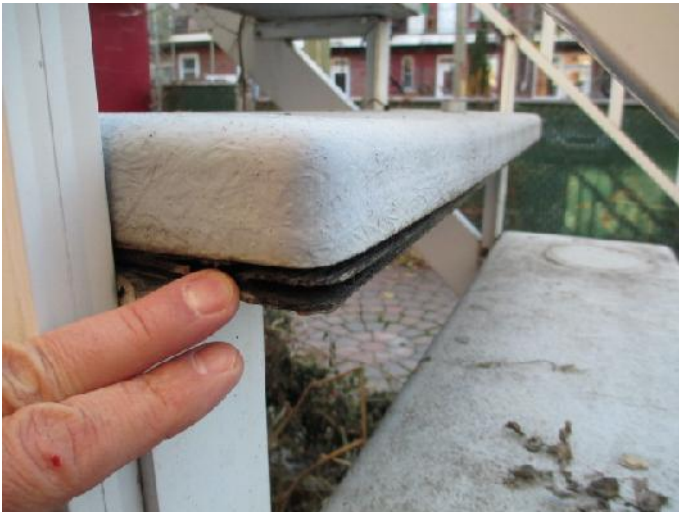
Figure 13- Séparation du joint entre le recouvrement de fibre de verre
