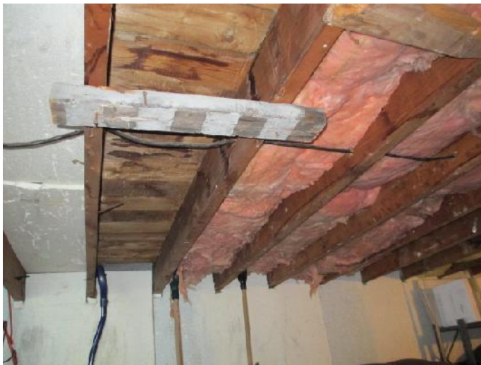
Figure 45- Installation incomplète et pas exécutée selon les règles de l'art
