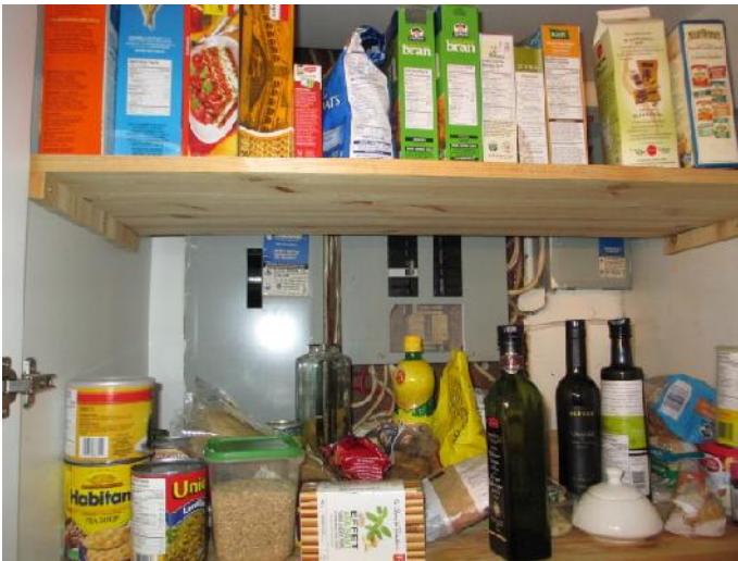
Figure 18- Garde-manger installé devant les accès électriques
