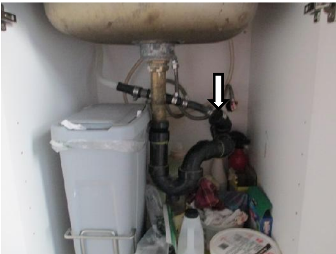
Figure 36- Vidange installée après le siphon
