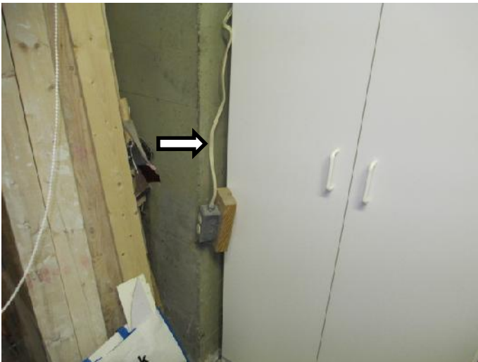
Figure 20- Fil électrique exposé et non sécurisé à la salle de chauffage
