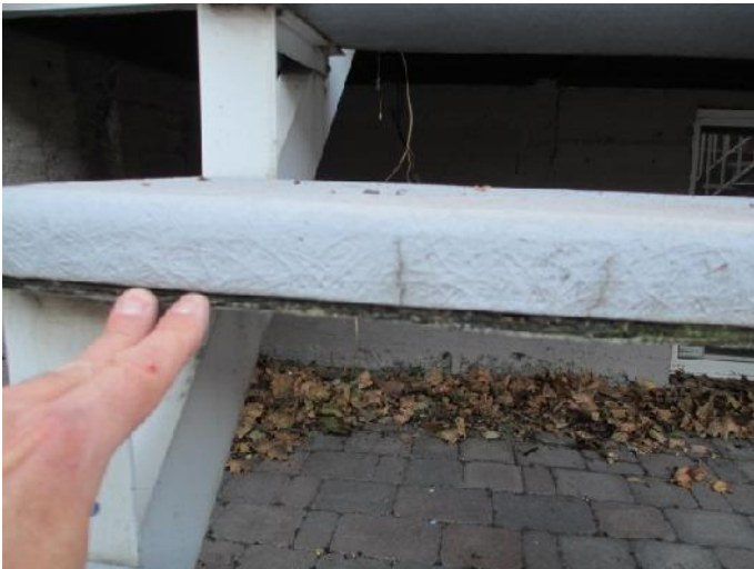
Figure 14- Séparation du joint entre le recouvrement de fibre de verre
