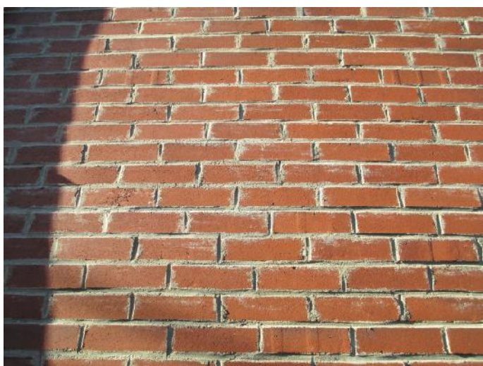
Figure 12- Maçonnerie mal nettoyée au mur gauche
