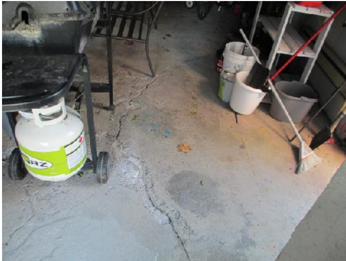
Figure 44- Dalle de béton au garage fissurée
