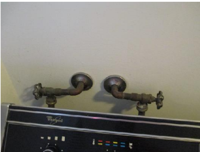
Figure 30- Tuyaux de lessiveuse à l'intérieur du mur arrière extérieur au 5294
