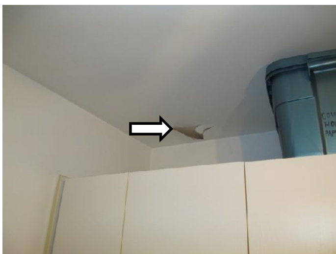
Figure 41- Peinture qui décolle au plafond de la salle de lavage au 5292
