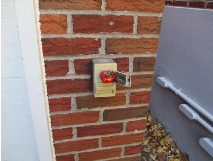
Figure 21- Prise extérieure au garage non protégée
