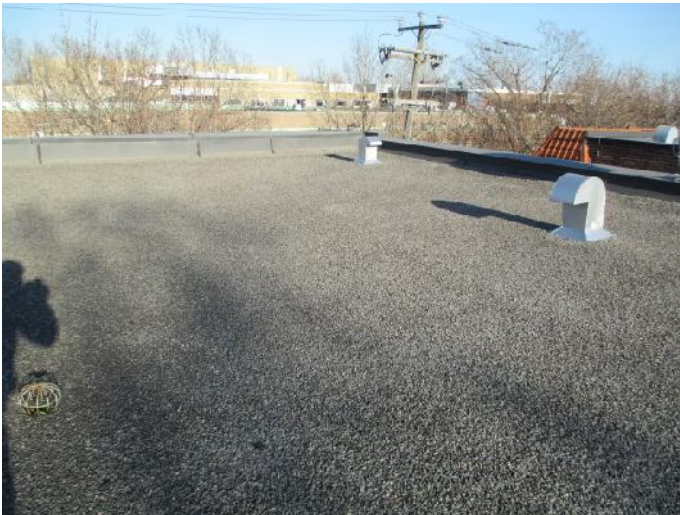
Figure 2- Vue partielle de la toiture vers l'avant
