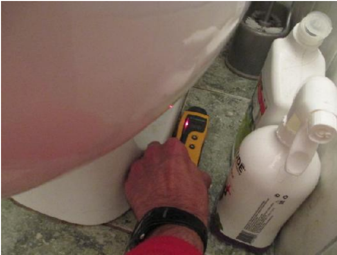
Figure 35- Humidité détectée sous le couvre plancher au #5292
