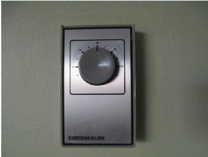
Figure 26- Thermostat biméallique
