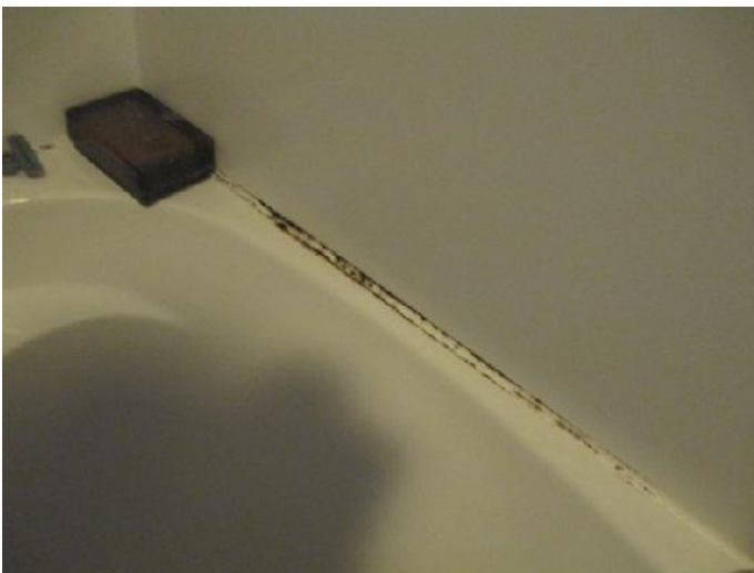
Figure 38- Apparence de moisissure autour de la baignoire au 5294
