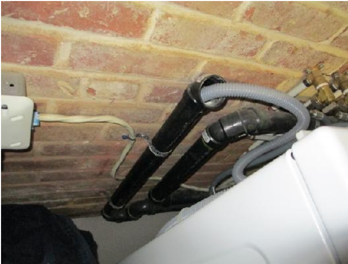
Figure 37- Ventilation du drain de laveuse au sous-sol à vérifier
