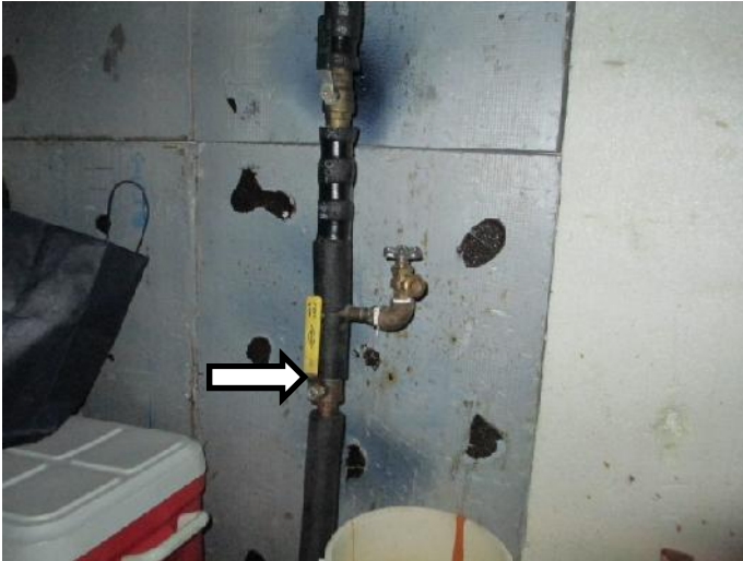
Figure 29- Valve de contrôle d'eau potable pour l'immeuble
