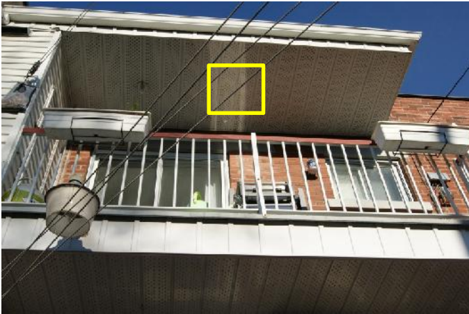
Figure 6- Ouverture manquante pour l'accès au toit
