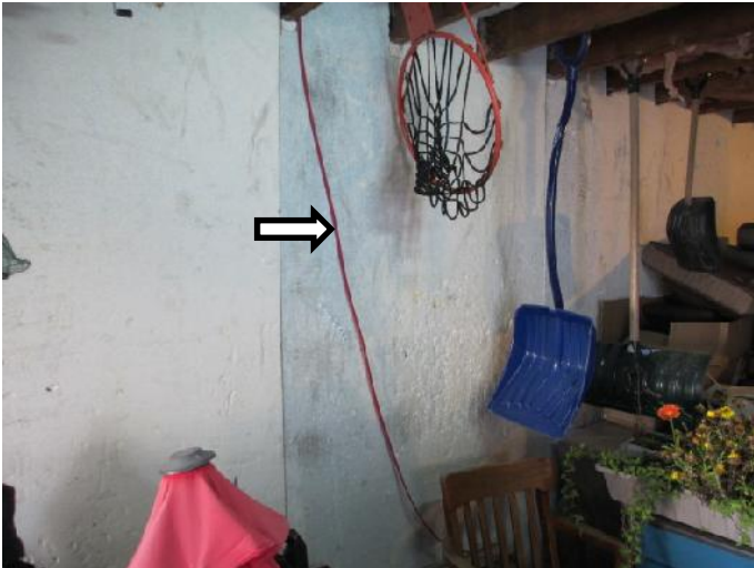
Figure 19- Fil électrique exposé et non sécurisé au garage
