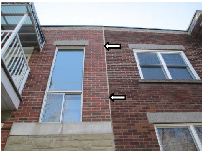
Figure 10- Joint de mortier mitoyen fissuré
