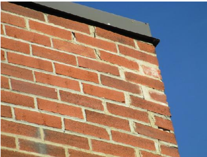
Figure 9- Joints de mortier fissurés au coin gauche arrière supérieur
