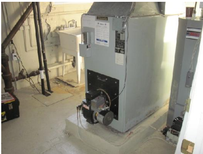
Figure 33- Fournaise au mazout à air chaud
