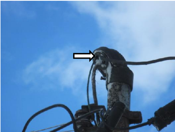
Figure 24- Partie exposée de la tête de branchement
