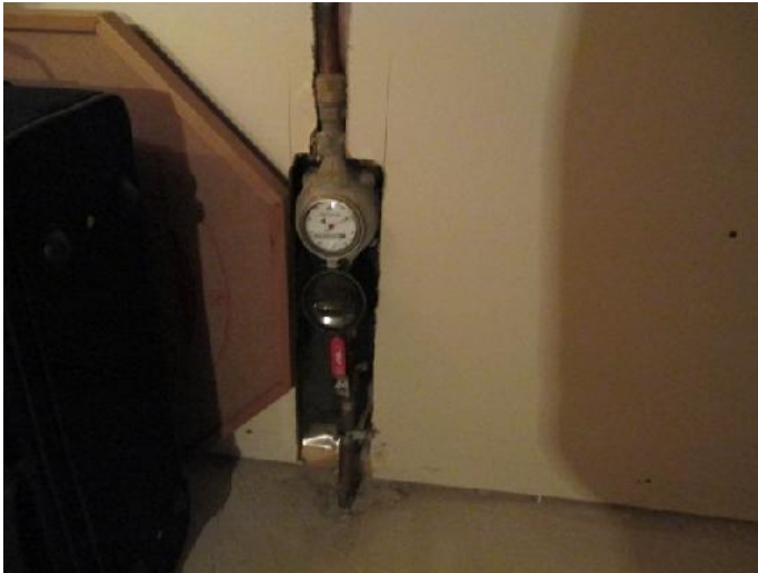
Figure 42- Valve de contrôle pour l'entrée d'eau principale
