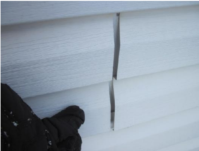
Figure 18- Installation non effectuée selon les règles de l'art
