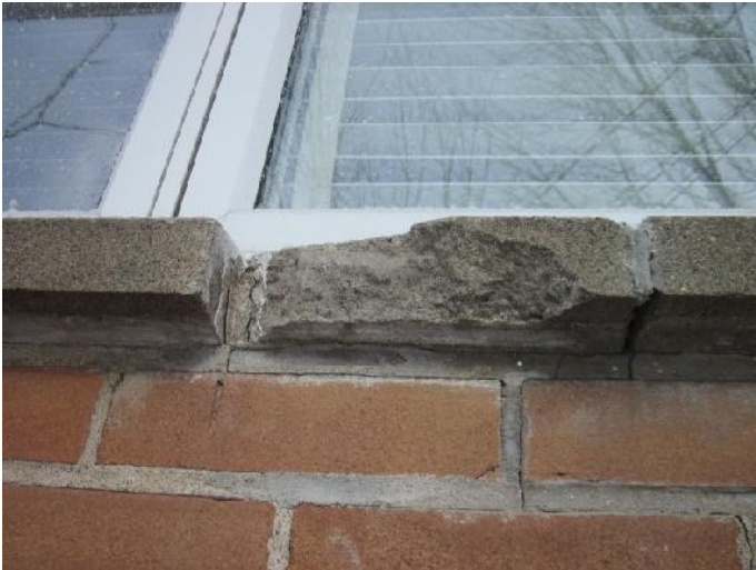
Figure 21- Allège de fenêtre endommagée au mur arrière
