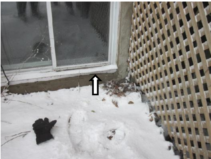
Figure 22- Calfeutrage non étanche à une fenêtre arrière
