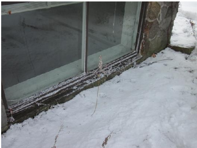
Figure 23- Dégagement insuffisant entre le bas de la fenêtre et le sol
