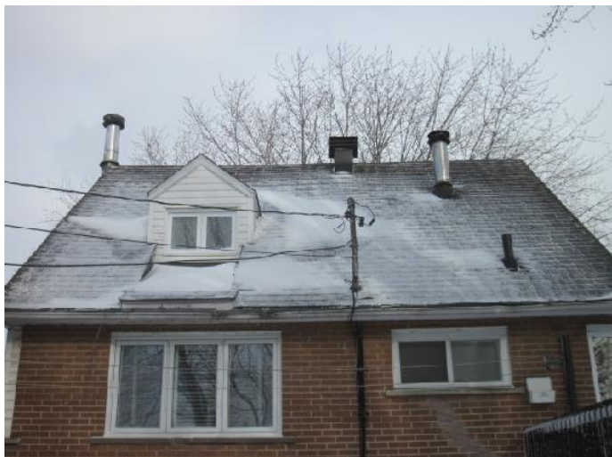
Figure 8- Vue partielle du toit côté arrière
