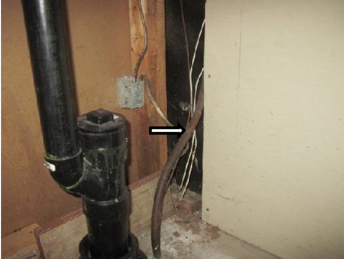
Figure 26 - Méthode d'attache du fil de mise à la terre non conforme
