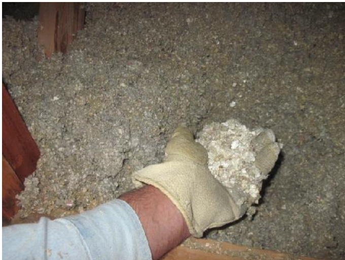
Figure 56- Vermiculite présente sous l'isolant de cellulose
