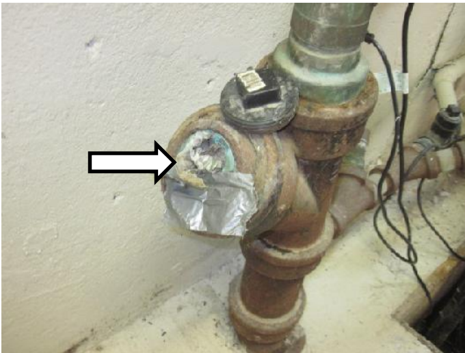
Figure 46- Regard de nettoyage endommagé - non étanche
