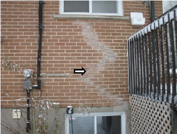
Figure 1- Fissure au mur arrière de la fondation causant une lézarde
