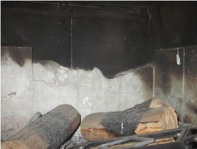
Figure 41- Briques réfractaires endommagées
