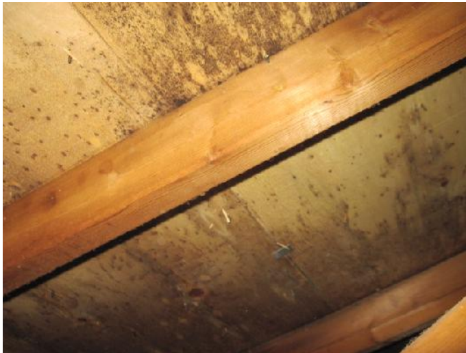
Figure 58- Apparence de moisissure dans l'entre-toit
