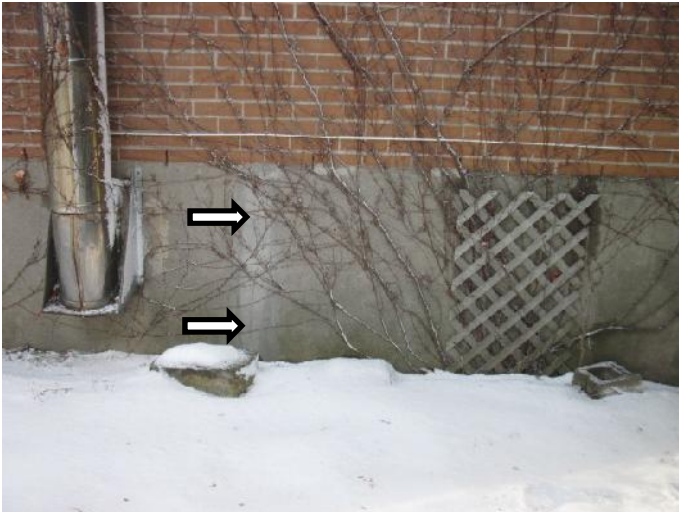
Figure 3- Fissure au mur droit
