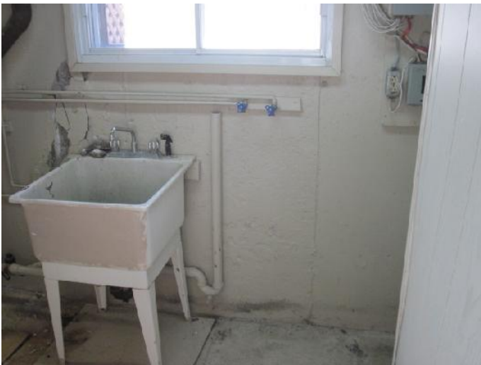
Figure 52- Installations de lavage au sous-sol
