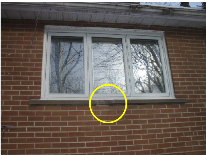
Figure 20- Allège de fenêtre endommagée au mur arrière
