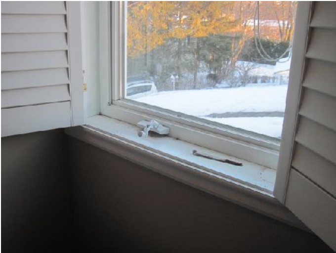
Figure 19- Mécanisme de fenêtre endommagé à la salle de bain au 2 e étage
