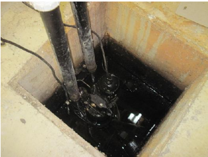
Figure 48- Bassin de captation au sous-sol
