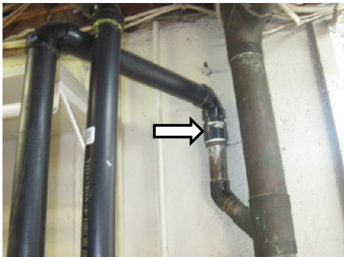
Figure 49- Déversement primaire du bassin dans la conduite sanitaire
