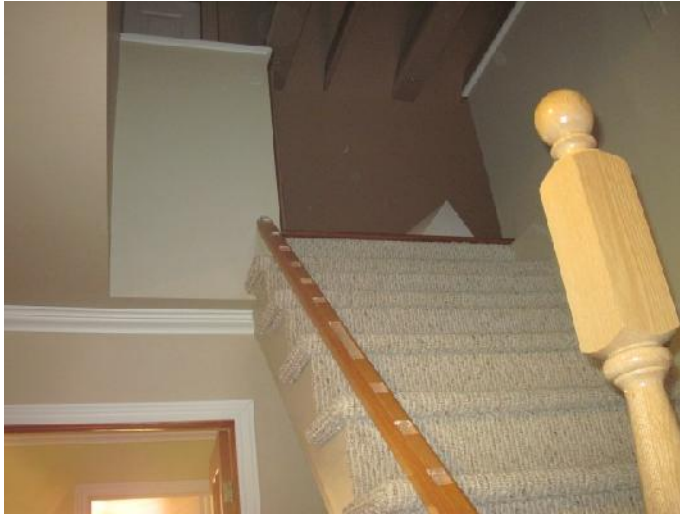
Figure 60- Absence de rampe dans les escaliers menant au 2e
