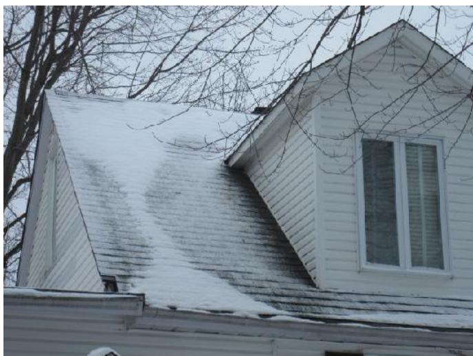
Figure 9- Vue partielle du toit côté avant
