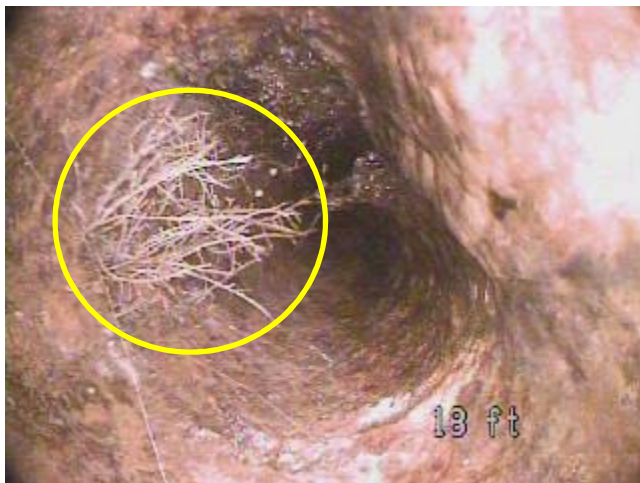
Figure 44- Infiltration de racines à l'intérieur de la conduite sanitaire
