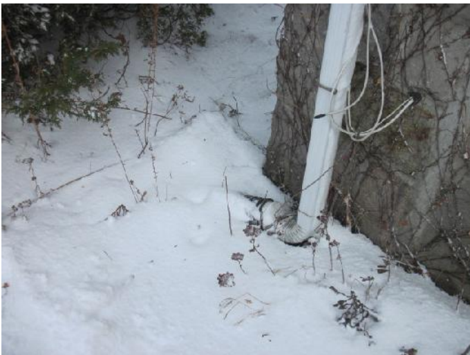
Figure 14- Gouttière se déversant dans du bigot perforé
