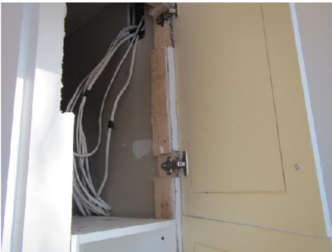
Figure 29- Installation de fils non conforme
