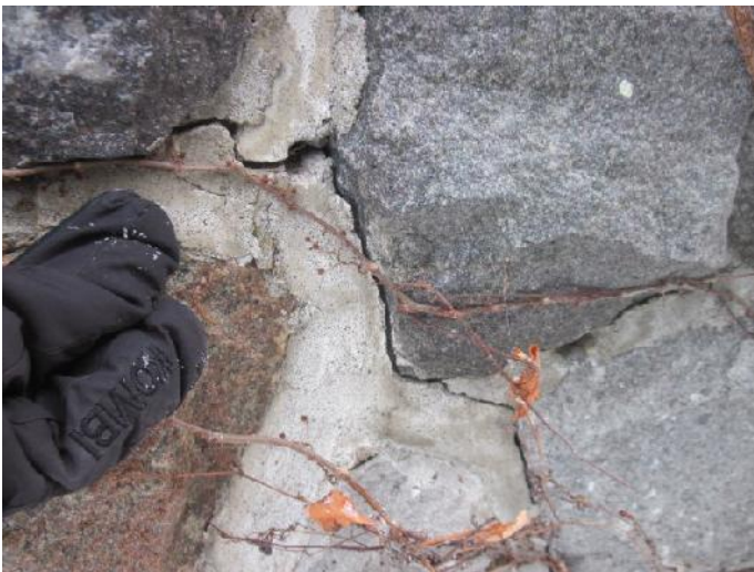
Figure 16- Fissuration du mortier au coin droit avant
