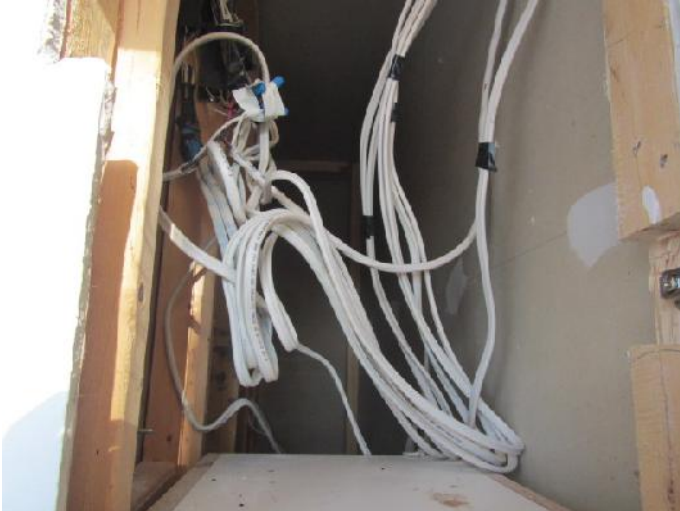
Figure 30- Installation de fils non conforme
