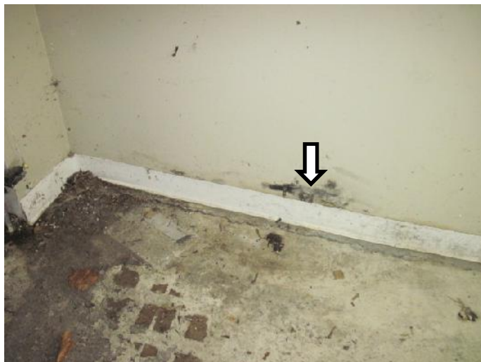
Figure 55- Apparence de moisissure au mur gauche intérieur au garage
