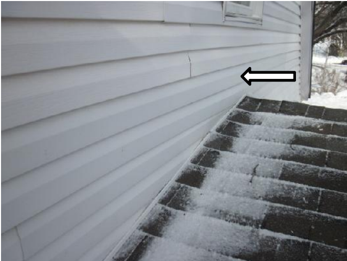
Figure 17- Bombement du revêtement de PVC au mur droit supérieur
