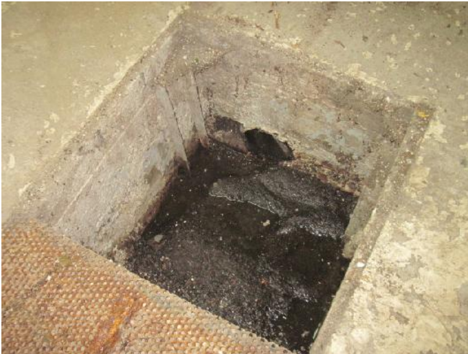
Figure 51- Bassin de captation au garage non étanche
