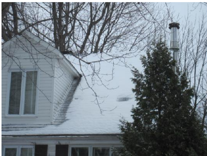
Figure 10- Vue partielle du toit côté avant
