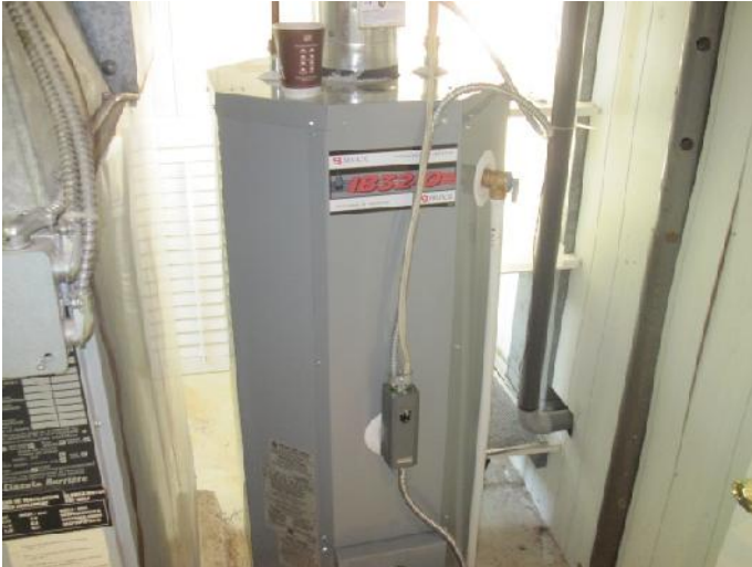
Figure 47- Chauffe-eau au mazout Brock modèle IB-32-0 no série: D011278184
