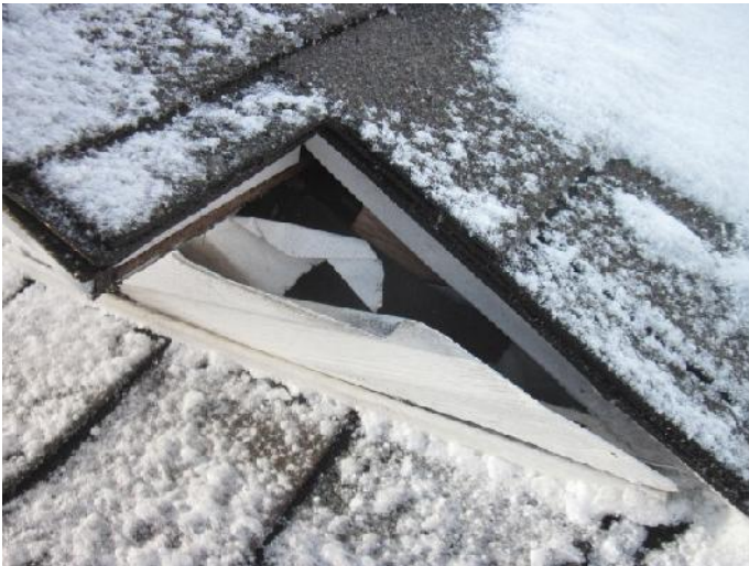
Figure 12- Installation de corniches inadéquates coin avant gauche
