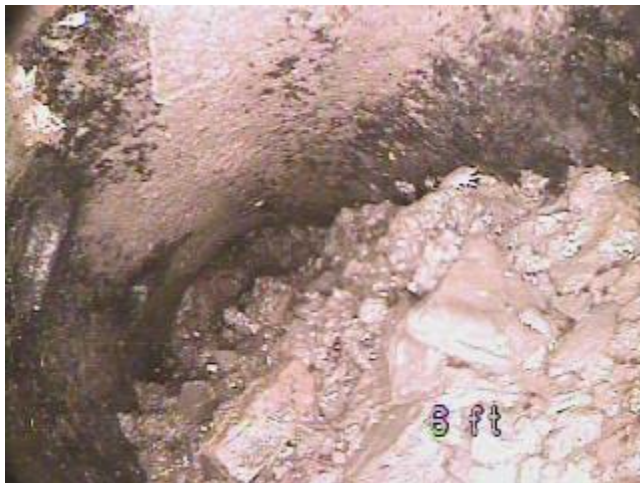
Figure 50- Drain français bloqué
