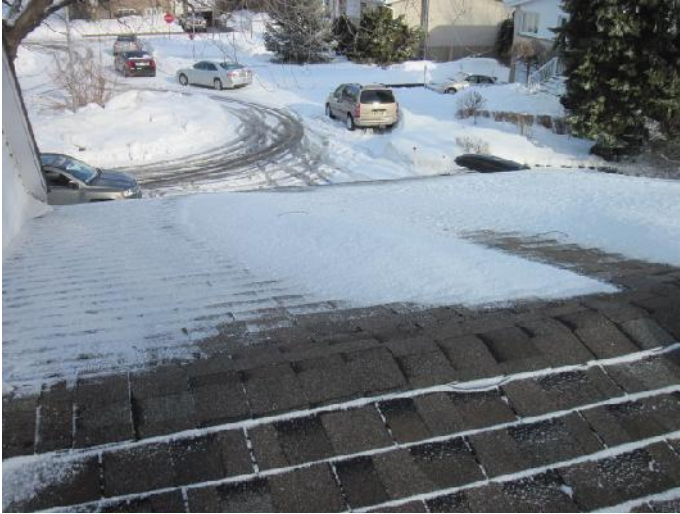
Figure 6- Vue partielle du toit à faible pente côté gauche avant
