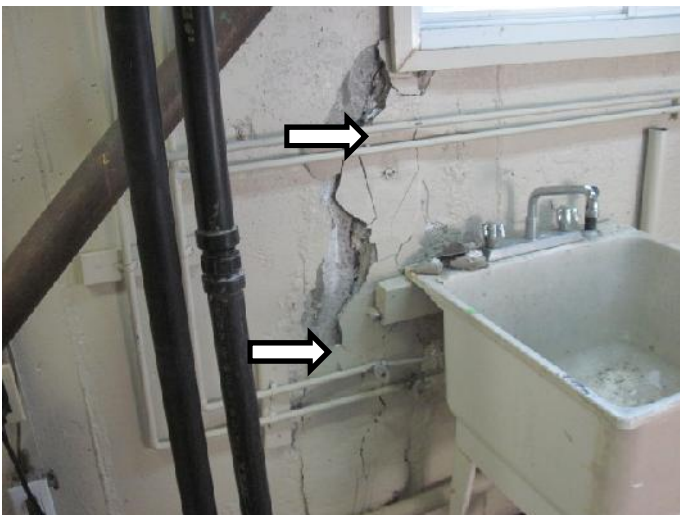
Figure 2- Fissure au mur arrière de la fondation vue de l'intérieur
