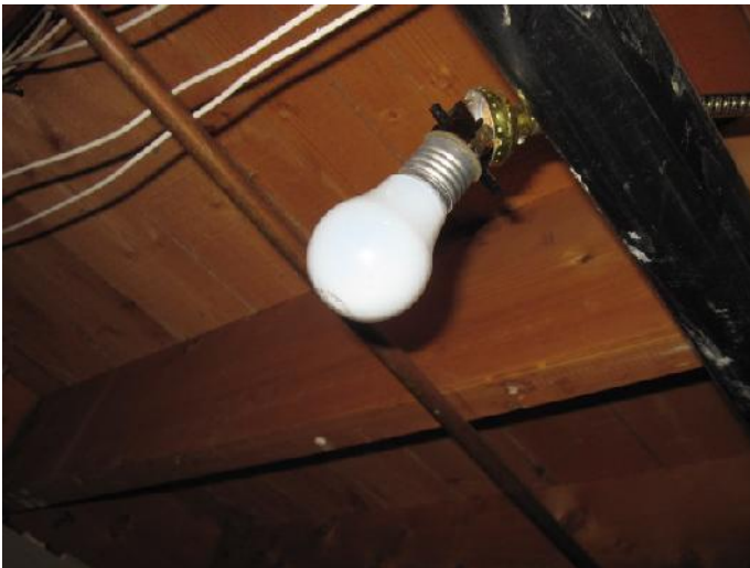
Figure 31- Installation de lumière défectueuse sous les escaliers
