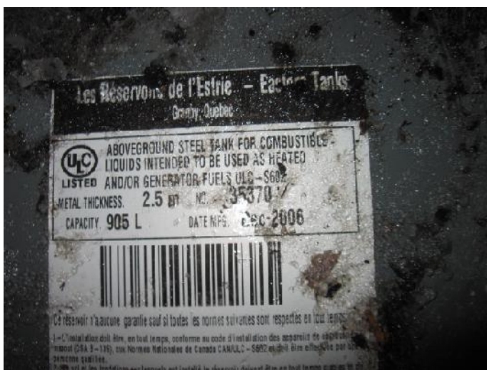
Figure 34- Plaque d'immatriculation du réservoir de mazout
