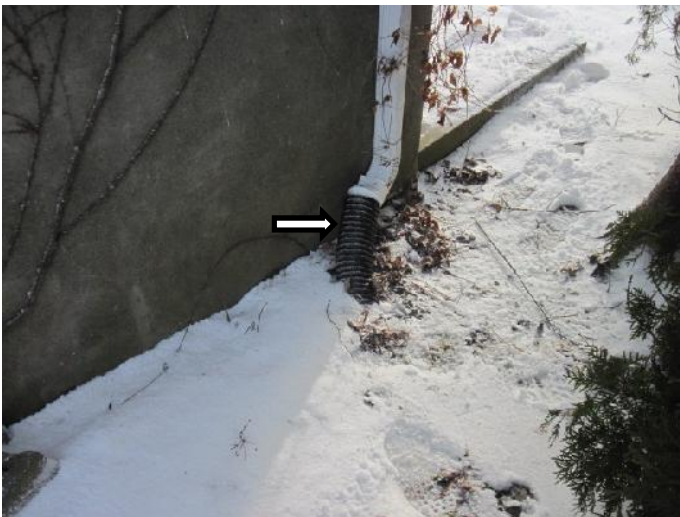
Figure 13- Gouttière se déversant dans du bigot perforé
