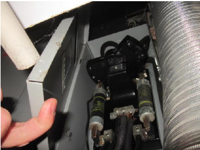
Figure 25- Vue intérieure du coffret de branchement
