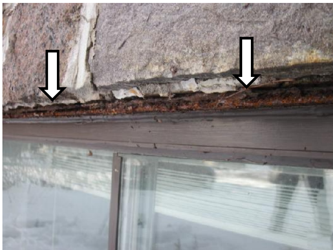
Figure 5- Linteau d'acier corrodé qui prend de l'expansion
