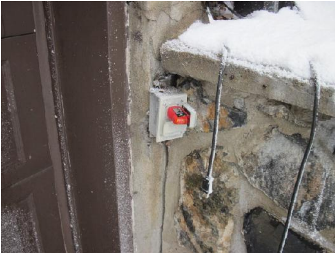
Figure 32- Prise non protégée à l'avant du bâtiment
