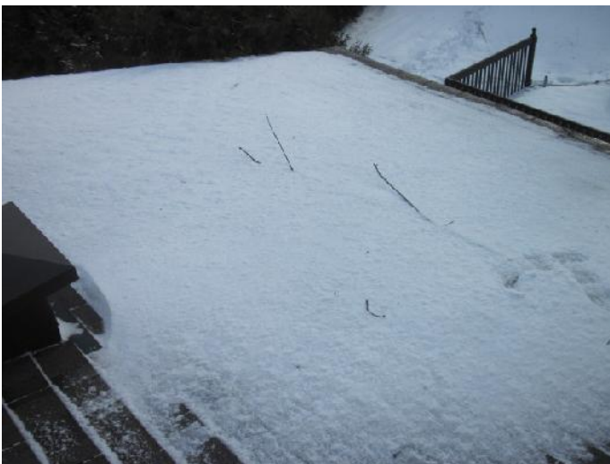
Figure 7- Vue partielle du toit à faible pente côté gauche arrière
