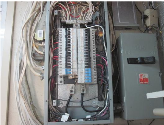
Figure 27- Vue intérieure du panneau de dérivation
