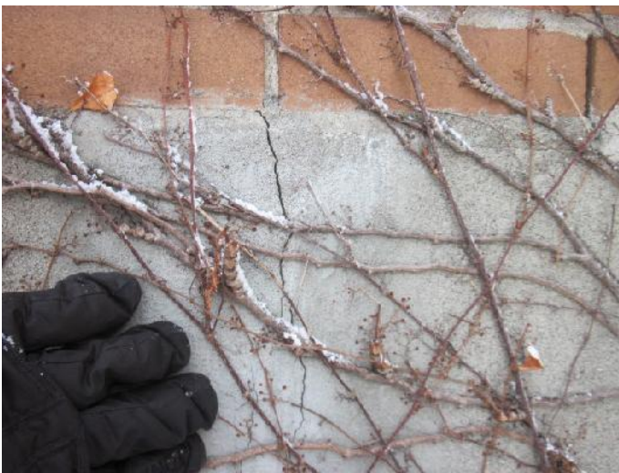
Figure 4- Fissure au mur droit
