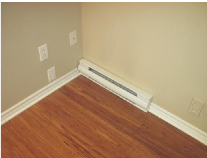
Figure 38- Une seule plinthe de 500 watts à la c.à c. au 2e
