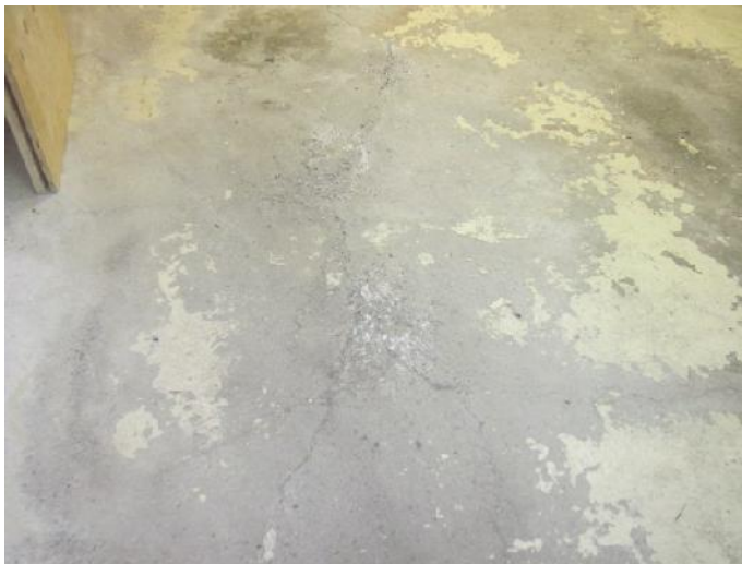
Figure 53- Dalle de béton fissurée au garage
