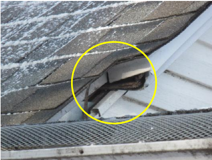
Figure 11- Installation de corniches inadéquates coin arrière gauche
