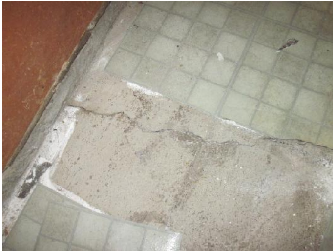
Figure 54- Fissure et légère dénivellation au plancher du sous-sol
