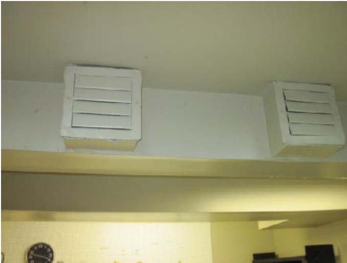
Figure 37- Conduits de chauffage dans le garage
