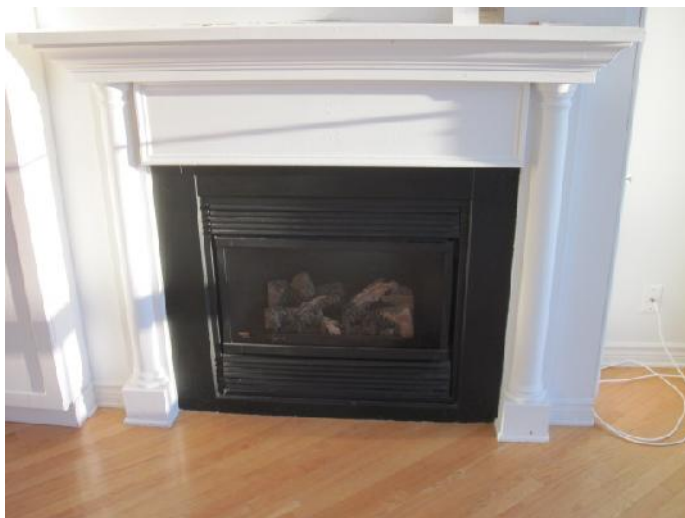
Figure 39- Foyer au gaz propane au rez-de-chaussée
