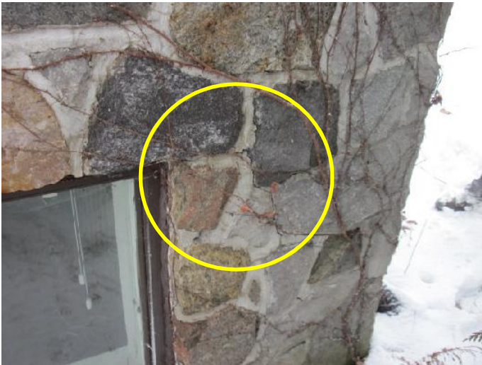
Figure 15- Fissuration du mortier au coin droit avant
