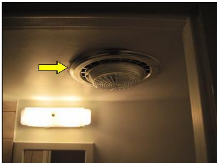
Basement bathroom exhaust fan
