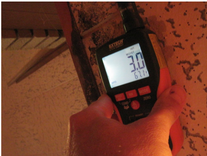
Figure 43- Vérification pour présence d'humidité
