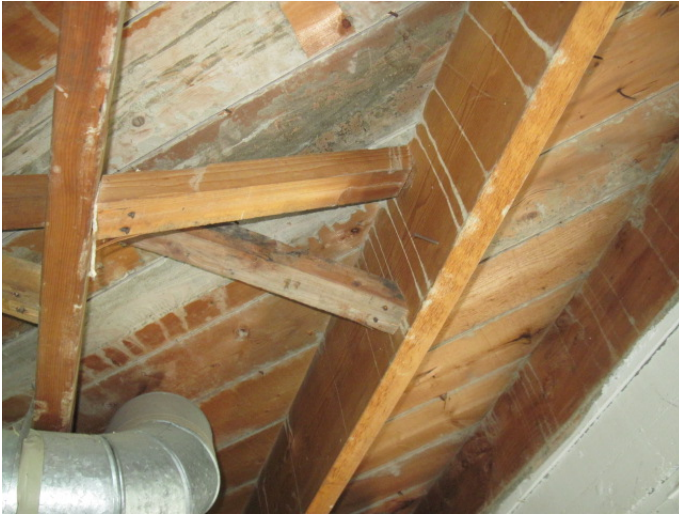
Figure 5- Vue partielle de la structure de plancher au sous-sol
