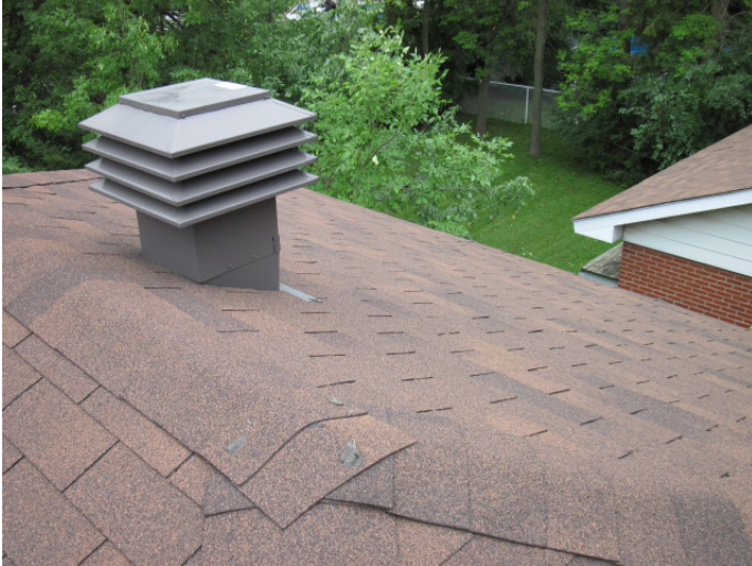
Figure 10- Vue de la toiture côté arrière
