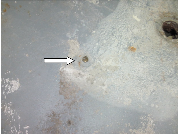
Figure 35- Drain de plancher fermé avec un capuchon
