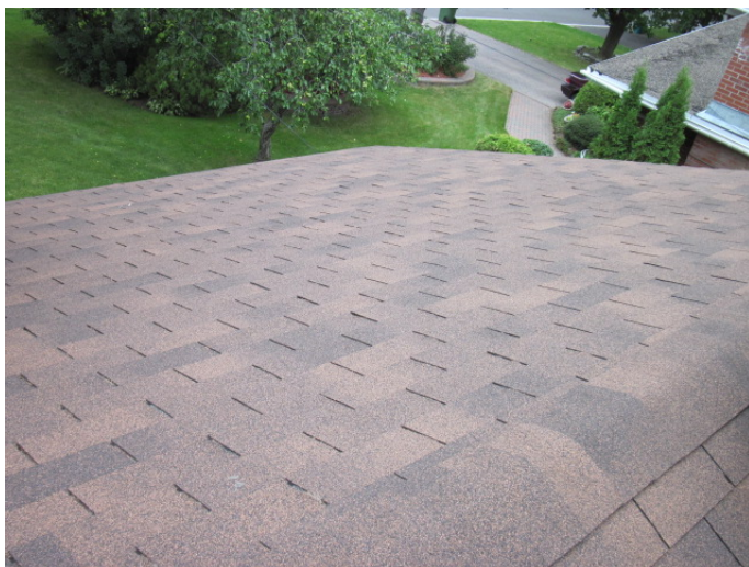
Figure 8- Vue de la toiture côté avant
