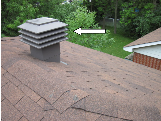
Figure 47- Ventilateur de toit de type Maximum
