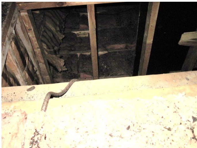
Figure 7- Vue partielle de la structure aux combles
