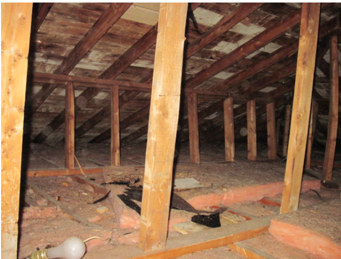
Figure 6- Vue partielle de la structure aux combles
