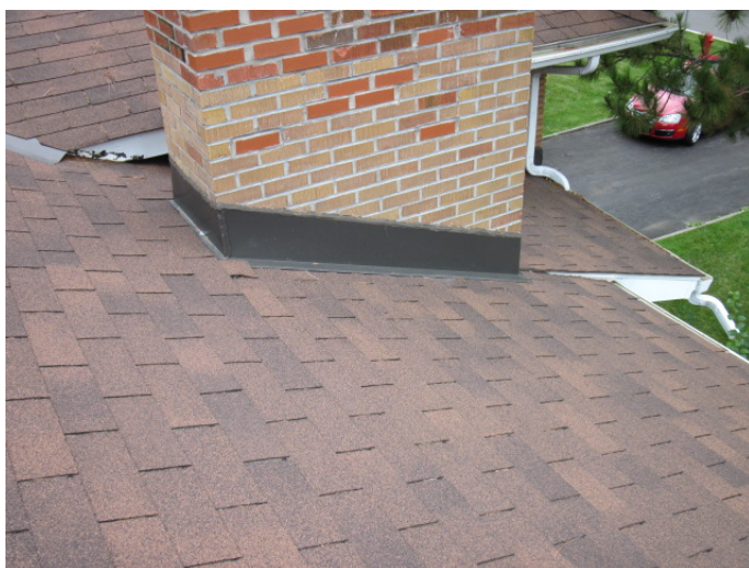
Figure 9- Vue de la toiture côté avant
